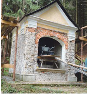
Kreuzwegstation während der Renovierungsmaßnahmen
